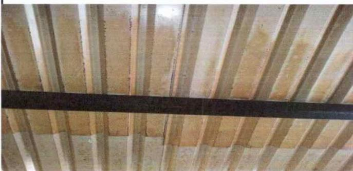
Pintura de lamina del techo de todo el edificio por estar oxidadas
